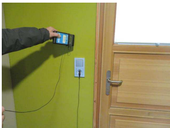
Zi 5 Wandlichtschalter E-Feld-Messung
